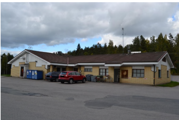
Kuvat 7-9. Vihtavuoren St1 -huoltoasema. (Laukaan modernin rakennusperinnön inventointiraportti. Mustonen A., 2013.)
